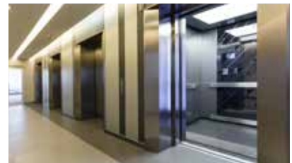
Elevador y barandal
